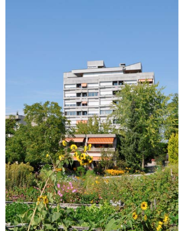
Die Idee des Gemeinschaftlichen Holzensteinerstrasse, Romanshorn, 1971 Nutzung / Typ: Seniorenresidenz, bis 8 G. Architekt: Adorni & Gisel Effektive Ausnutzung: 0,5
