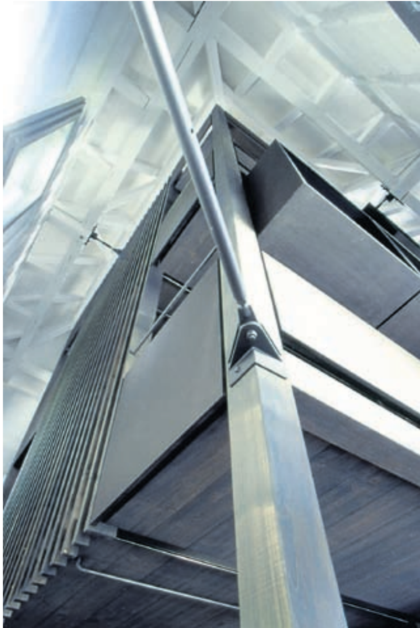
Der neue Einbau berührt das alte Mauerwerk an keiner Stelle. Bild: Jürg Zimmermann
