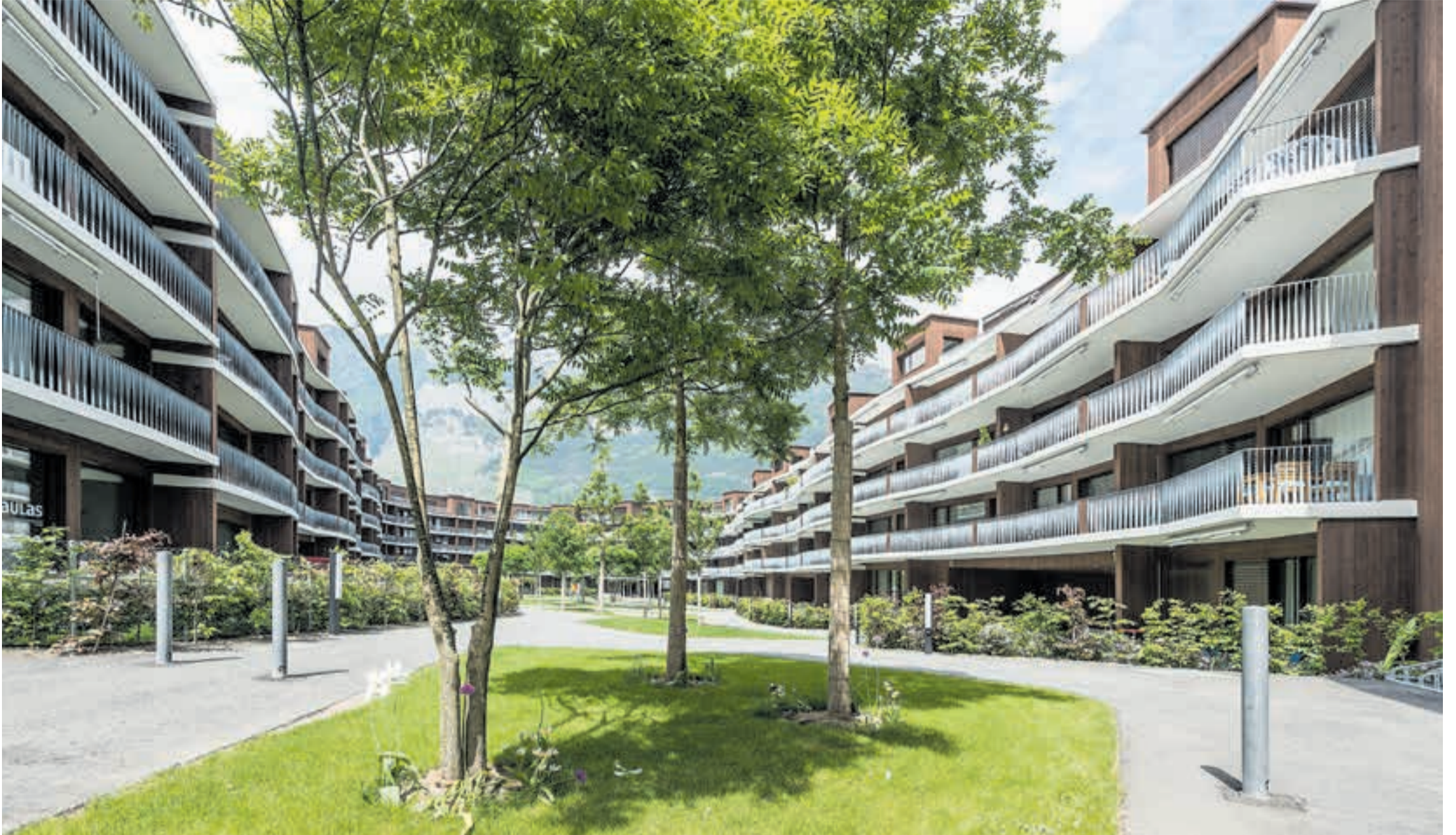
Wohnüberbauung Pulvermühle in Chur von Conradin Clavout, Landschaftsarchitekten Müller Illien. Hier wurde die Tiefgarage nicht unter das ganze Areal gelegt, sondern nur unter den Wohnbau. Bilder: Hanspeter Schiess
