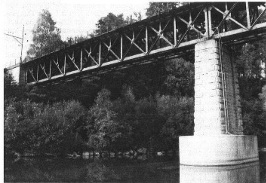
Bild 4. Der Sitterviadukt der Bischofszeller Bahn zwischen Sitterdorf und Bischofszell. Erbaut 1874-1876 durch O. Geiger als Unternehmer unter Oberingenieur Th. Ammann als Vertreter der Bauherrschaft. (Foto: E. Müller, Fruthtwilen)
