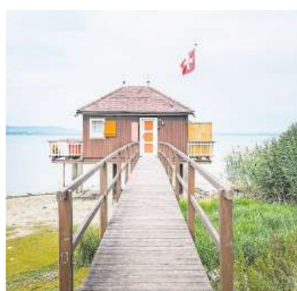
Eines von zehn Badehäuschen, die von 1929 bis 1934 zwischen Kesswil und Uttwil erbaut worden sind.
