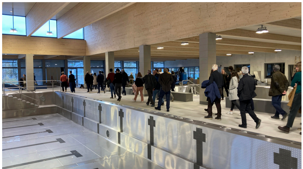
Neubau Hallenbad Frauenfeld (Bild: Felix Rutishauser)
